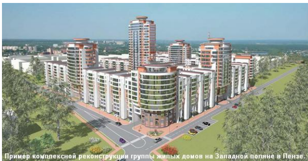
Пример комплексной реконструкции группы жилых домов на Западной поляне в Пензе.
